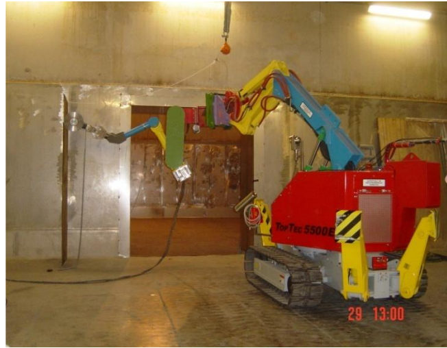
OilQuick OQ 60 специальная версия при сносных работах на атомных электростанциях
