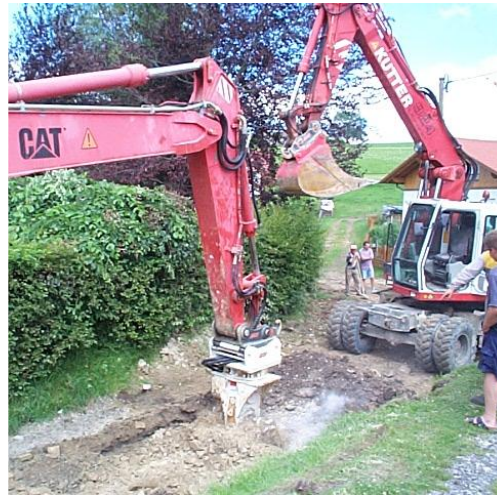
OilQuick OQ 70/55 работа в траншее, с фрезой и методом обратной лопаты
