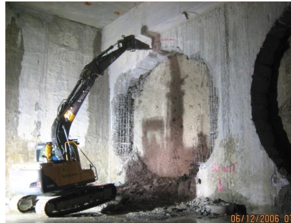
OQ 70 при туннельном строительстве
