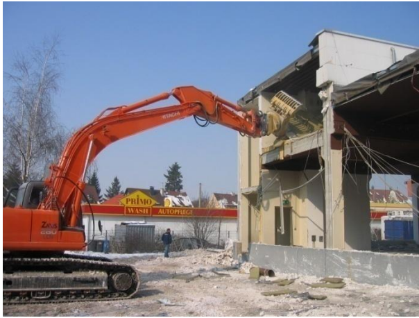
OilQuick с сортировочным грейфером и гидравлическим измельчителем
